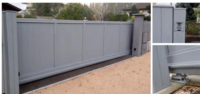
Un portail coulissant autoportant qui ne nécessite aucun rail au sol pour assurer son ouverture ou sa fermeture. Le portail n'est jamais au contact avec le sol et est suspendu par le biais de ses roulettes.
